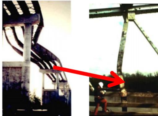
**Desgarre de la soldadura:** El cordón de la soldadura que une los elementos de acero se desgarra, separando los elementos estructurales.
