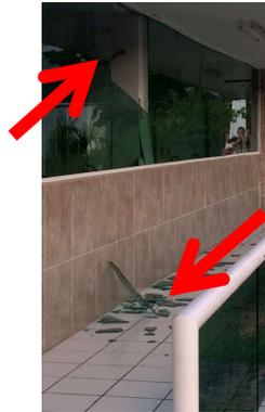
**Desprendimiento de acabados:** Estos elementos no son estructurales, pues se dañan con facilidad debido a los fuertes movimientos ocurridos durante un sismo. Su caída no representa un daño grave en la estructura del inmueble. Como acción preventiva se puede acordonar la zona hasta que se realice el retiro de los elementos dañados y se limpie la zona afectada.
