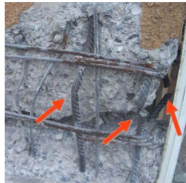
Estallamiento de concreto y pandeo de varillas visibles en la base de las columnas
